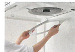
古い換気扇は取り外して廃棄。
